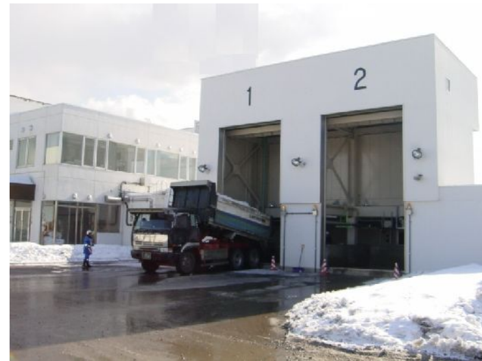
Tanque para derretir nieve
