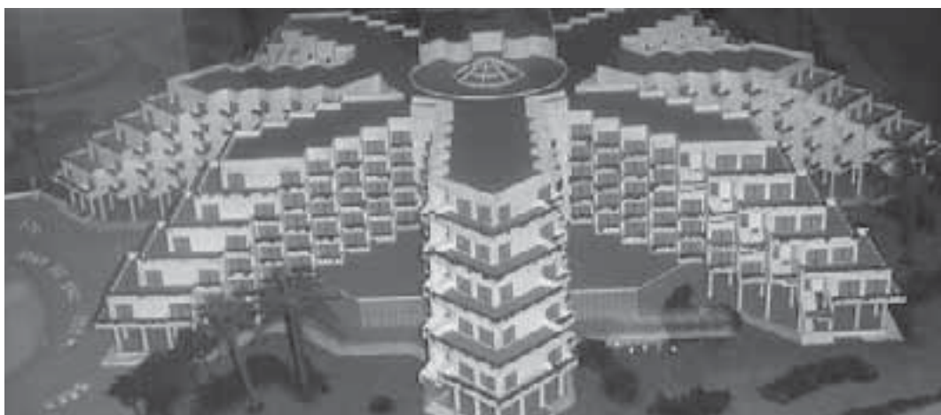
Fig. 7. Hotel Meliá Varadero. Su forma de pétalos le permite aprovechar casi todos los rumbos de viento para su refrescamiento natural. Su patio interior se convierte en una "chimenea", por la que se expulsa el aire caliente. Las paredes del patio interior se encuentran cubiertas de vegetación colgante, lo que absorbe calor en el proceso de evapotranspiración. A través de las puertas de los pétalos, penetra un aire más fresco, manteniendo una ventilación que resulta en una temperatura más confortable durante la mayor parte del año (Fuente: CIGET).
